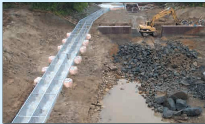
ジャスト・イン組立式水路による水替
