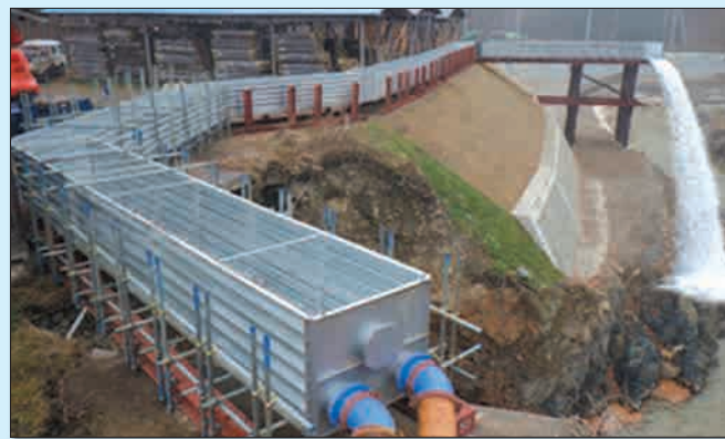
組立式水路を送水管として使用
